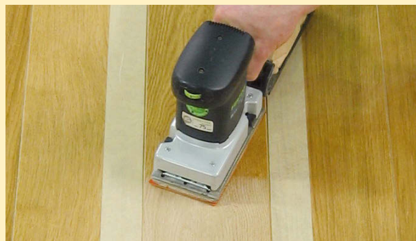
Slip den skadede overflaten grundig.
