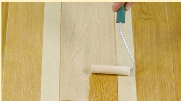
Påfør Osmo Hardvoksolje tynt med Mikrofiberrullen.
